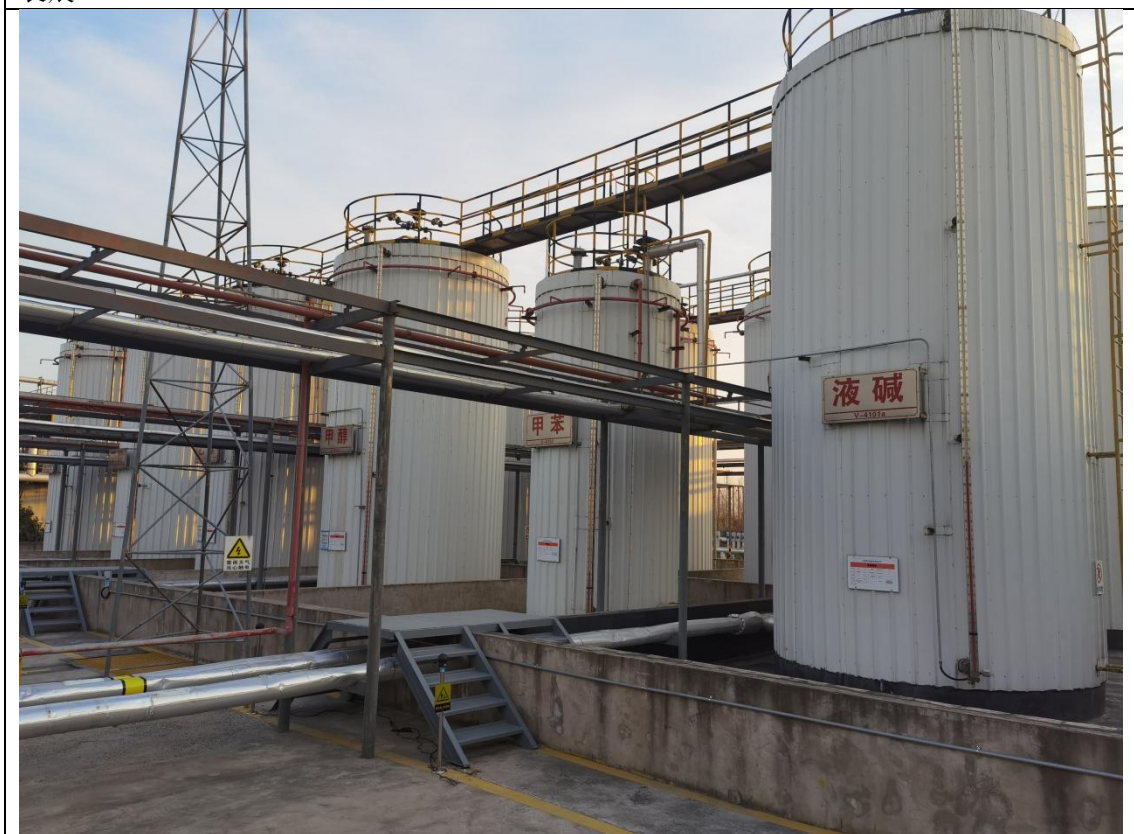
仓储区：储罐区均设置有隔水围堰，地面完好无破损。
